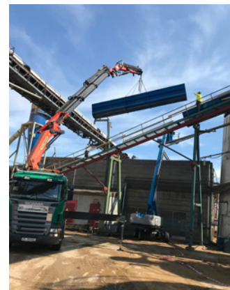
Bilde: Ny transportør for råspen er produsert ved Forestia i sommer og denne ble montert under sommervedlikeholdet.
