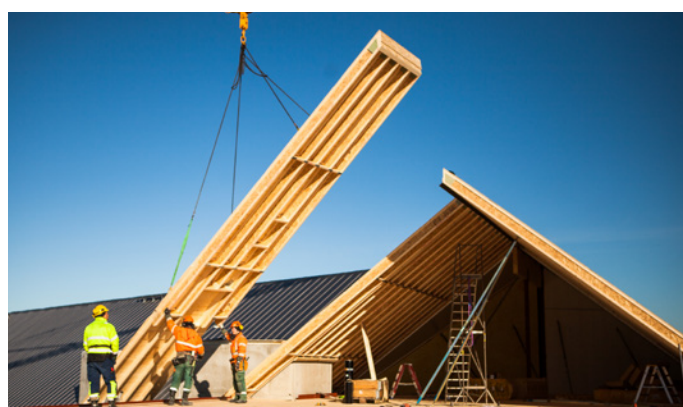
I-BJELKE BRUKT I FERDIGELEMENTER
